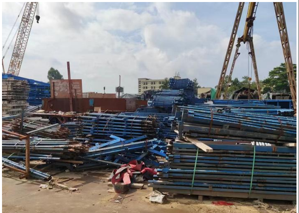
南面 中铁十五局集团城市轨道交通工程有限公司堆场
