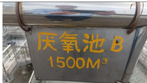
废水处理站厌氧池 B 标识牌
