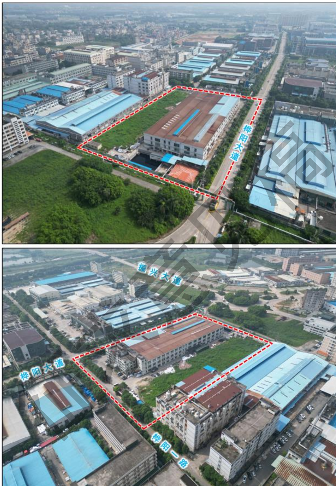
2-2 现状航拍照片
