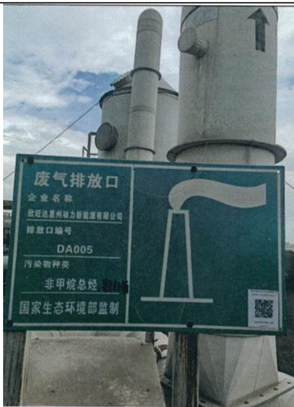
2 栋注液废气排放口 2(DA005)
