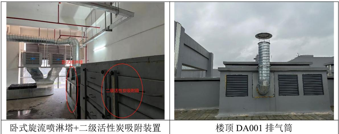
图 1-6 项目废气处理设施实景照片
