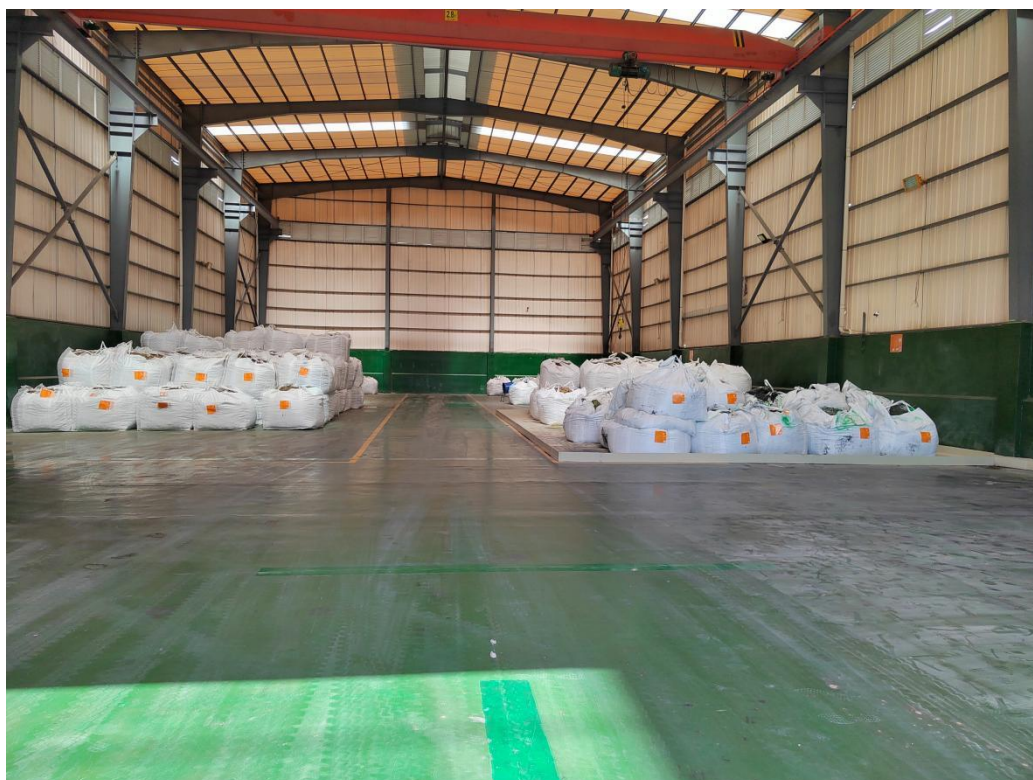
图 3.3-8 污泥仓库现场照片
