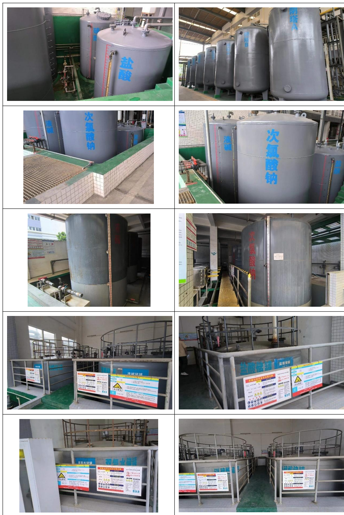
图 3.3-2 厂区地下及半地下储罐照片
