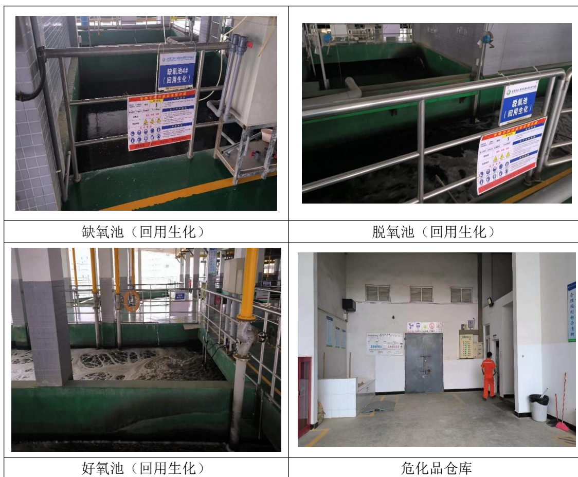
图 4.1-1 现场踏勘照片
