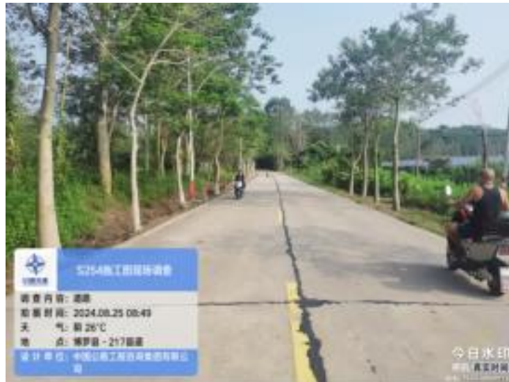
图 2-3 现状水泥混凝土路面
