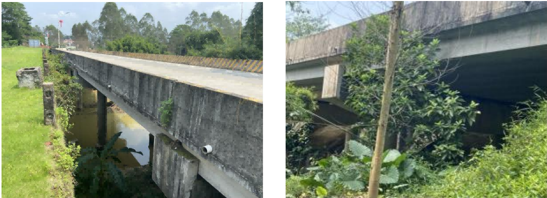
图 2-18 湖镇桥现状照片
