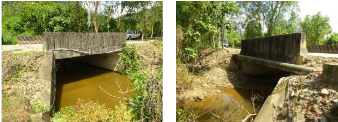
图 2-15 河口小桥现状照片
