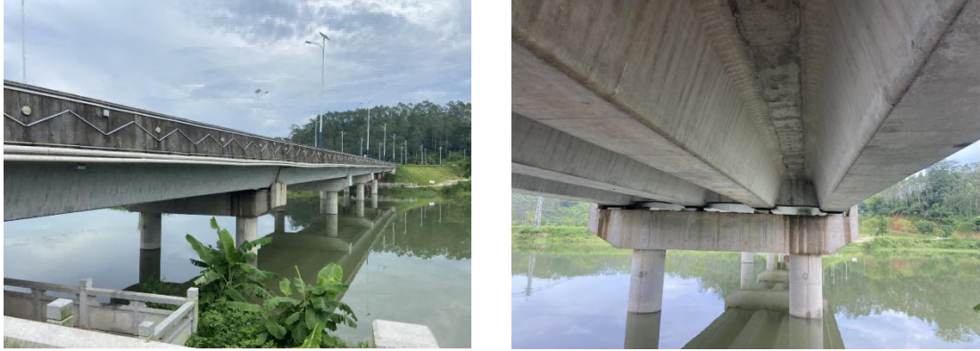
图 2-17 横河大桥现状照片
