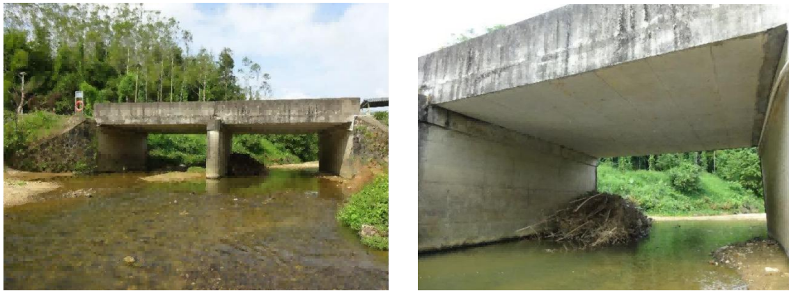
图 2-12 岗下小桥现状照片
