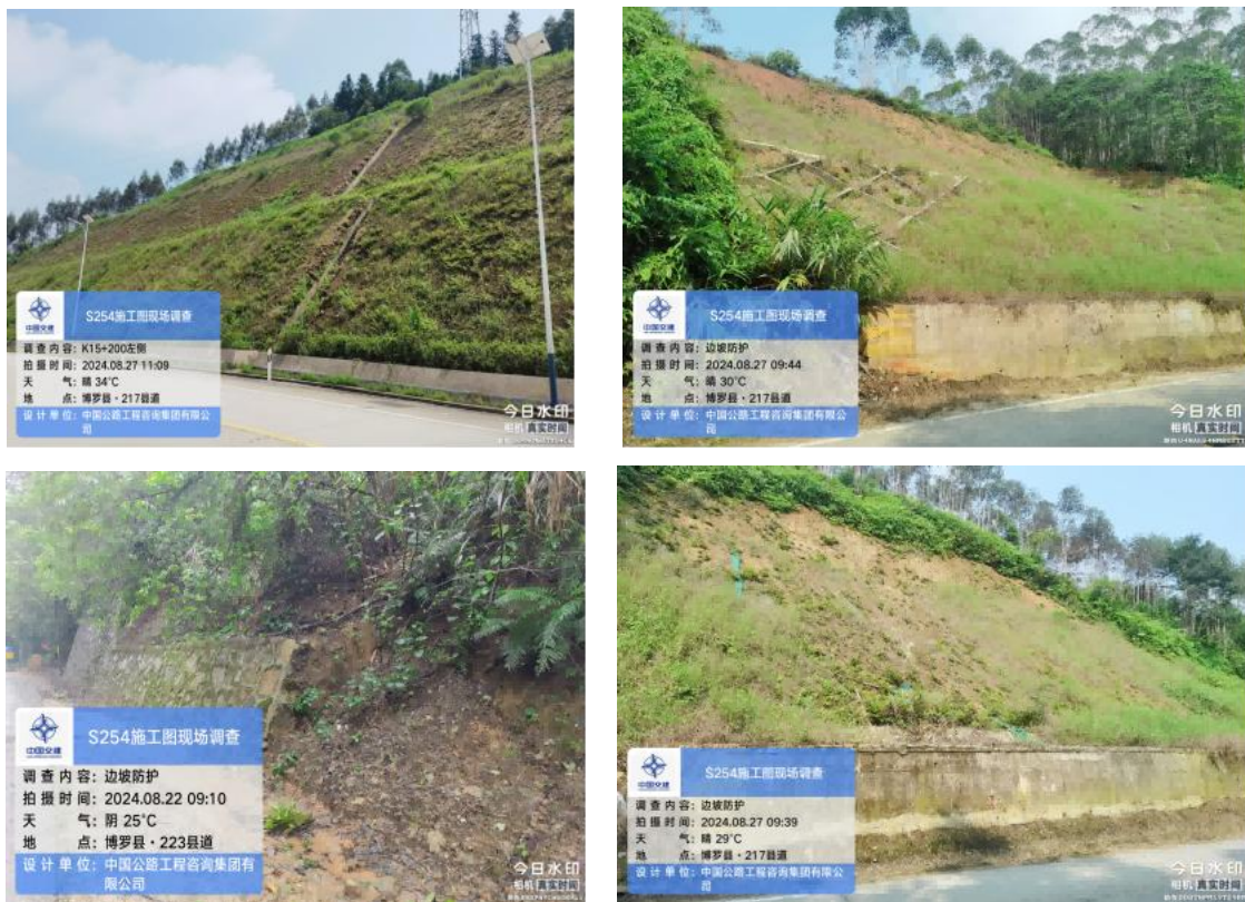
图 2-1 S254 现状路基防护情况
