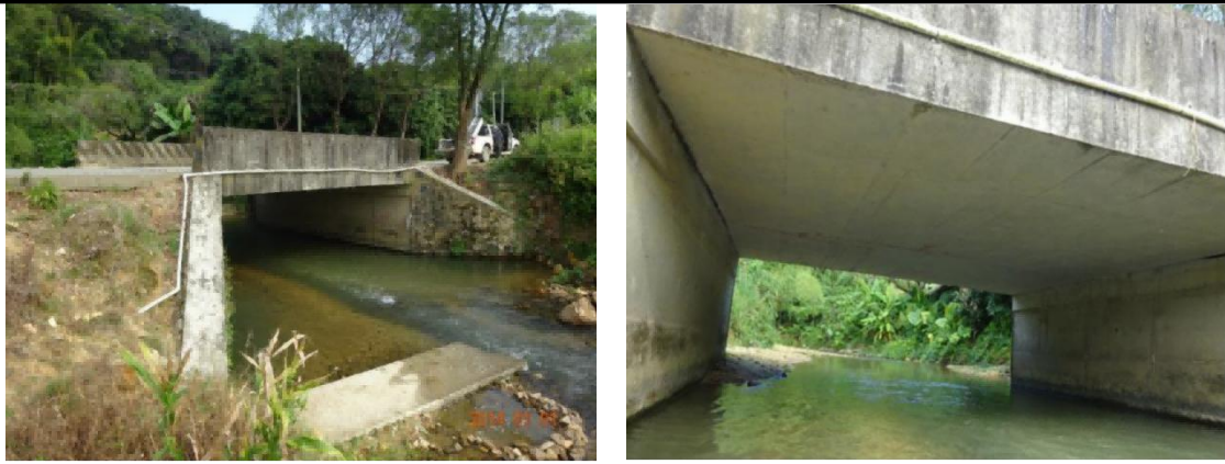
图 2-11 田寮小桥现状照片
