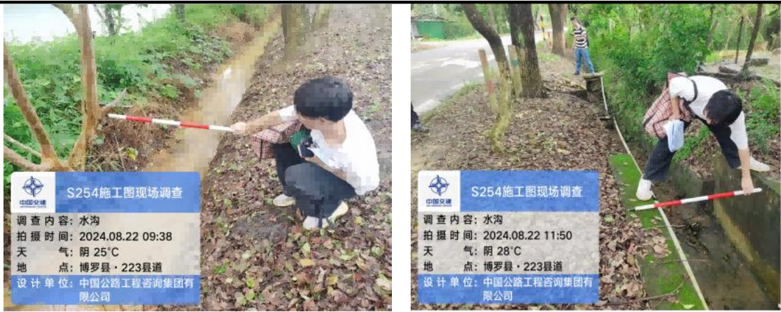
图 2-2 S254 现状排水情况
