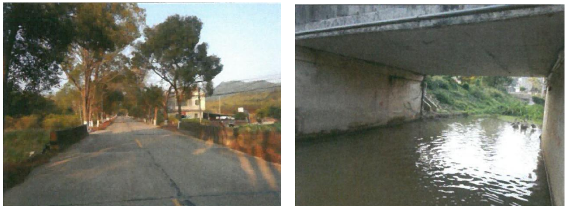
图 2-13 横岗岭小桥现状照片
