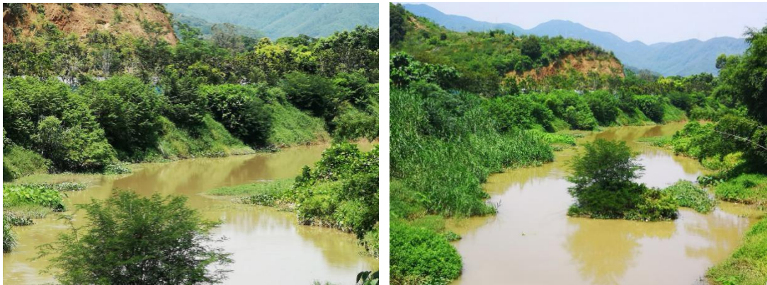
图 2-24~25 项目区南侧榕溪淤现状
