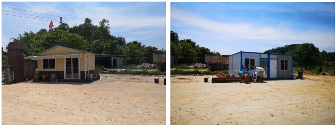
图 2-2~3 项目区出入口现状
