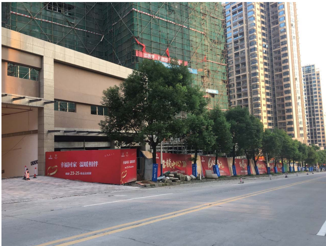
图 2-4 西北侧的 23#~33#楼正在施工
