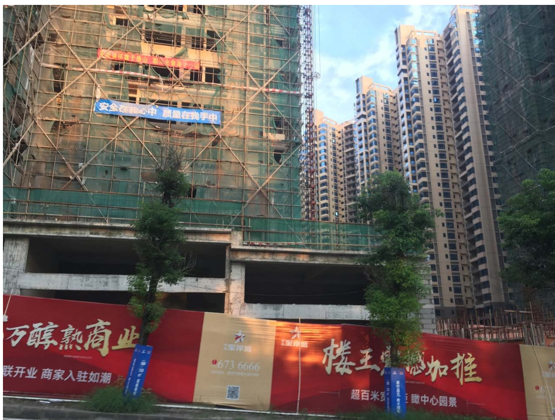
图 2-5 西北侧的 23#~33#楼正在施工
