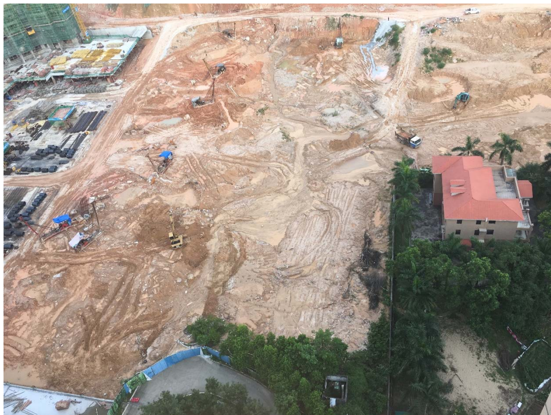
图 2-7 东侧区域正在施工
