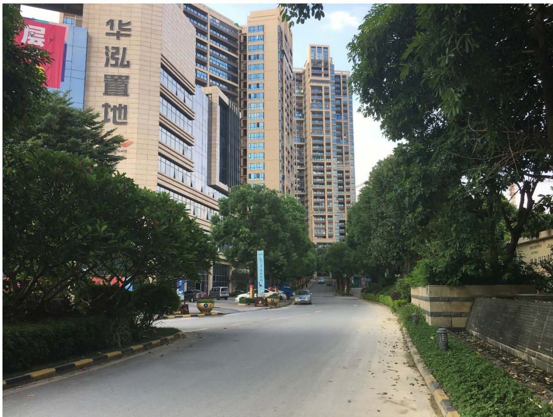
图 2-2 西南侧的 1#~13#楼已建成
