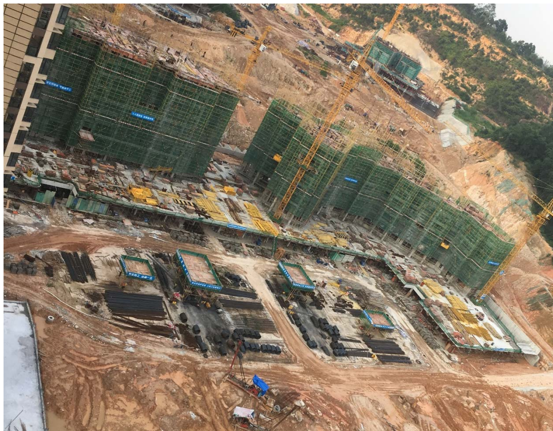
图 2-6 东侧区域正在施工
