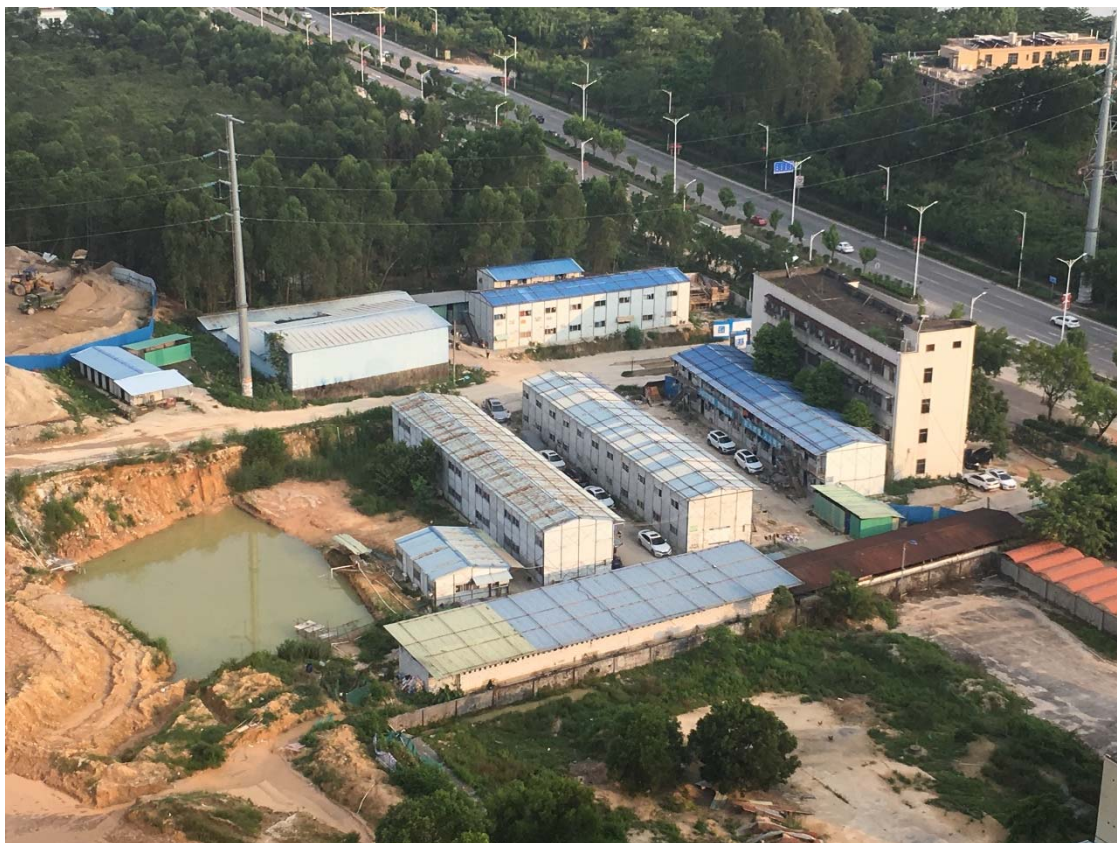
图 2-8 施工营造区布置于项目区东南侧
