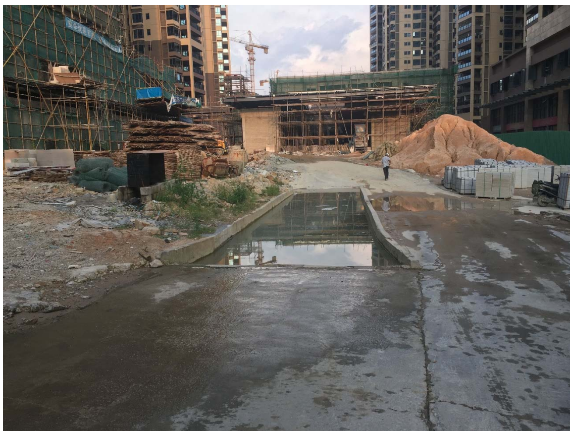
图 2-9 施工车辆出入口设置了洗车池
